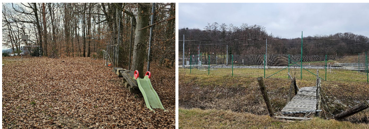
Sliki 54a in b: Primera slabo vzdrževane rekreacijske infrastrukture: levo: večnamensko igrišče v Strmcu pri Ormožu; desno: nogometno igrišče pri PGD Žerovinci (foto: Pina Klara Petrovič Jesenovec)
